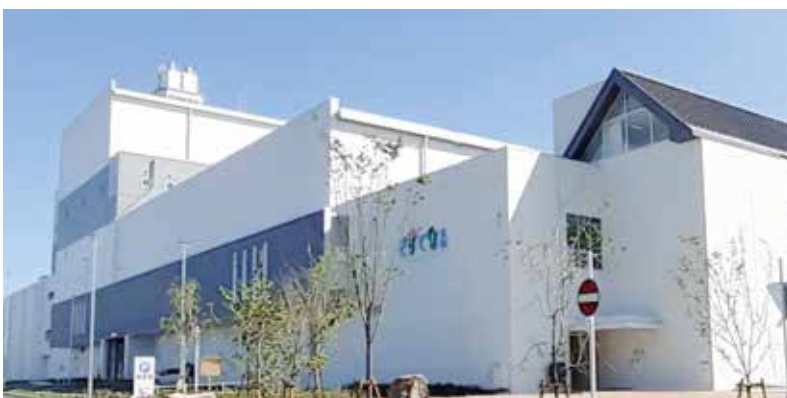
南部クリーンセンター環境学習施設「さすてな京都」（10月5日オープン）
