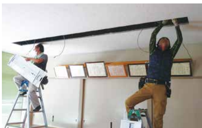
【向島藤ノ木学区「地球温暖化による災害を減らそう！向島藤ノ木節電所」】 地域の自治会館の照明をLEDに改修している様子
