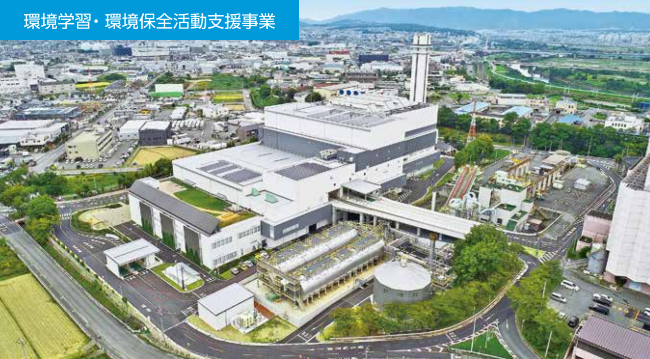
2019年度に改装オープンした京都市南部クリーンセンター第2工場全景
